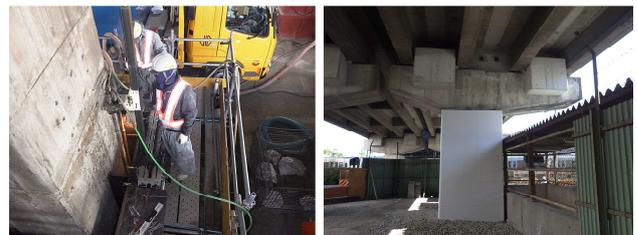
写真-2 名月陸橋施工状況・完成状況
